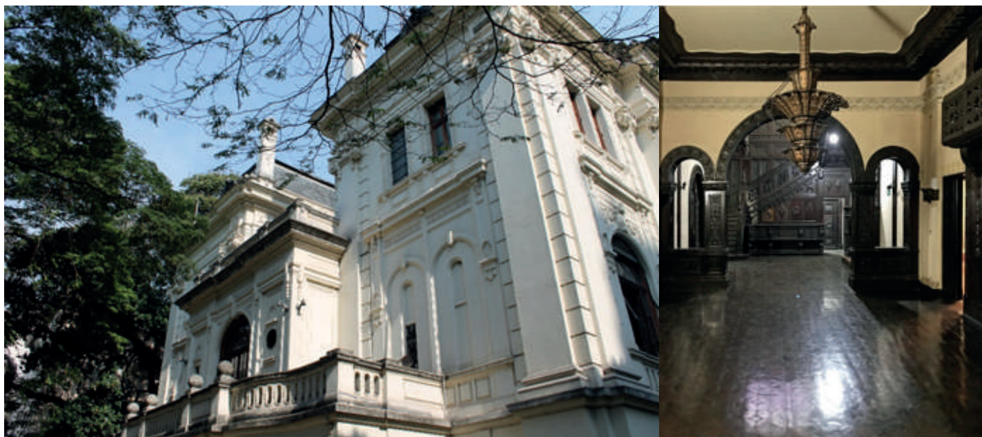
Fotos do Casarão Nhonô Magalhães, que atualmente está em processo de restauração.
